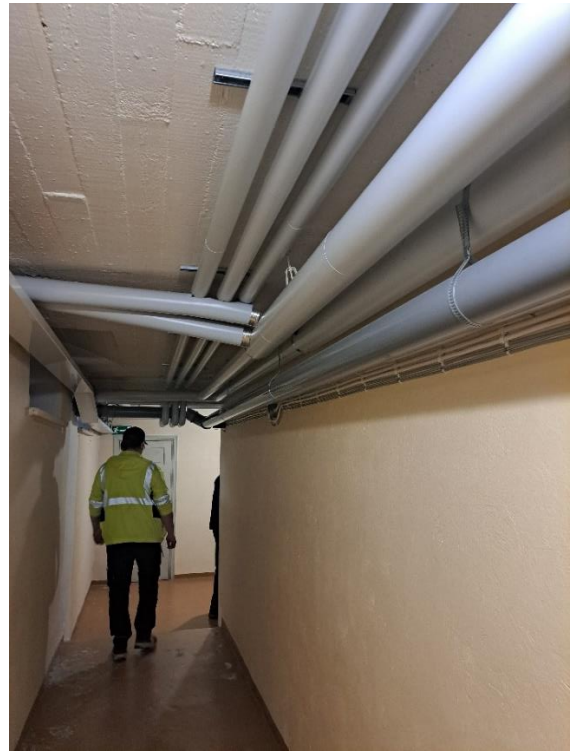
Kuva LVI 8: Uusittuja vesijohdon runkoputkia
