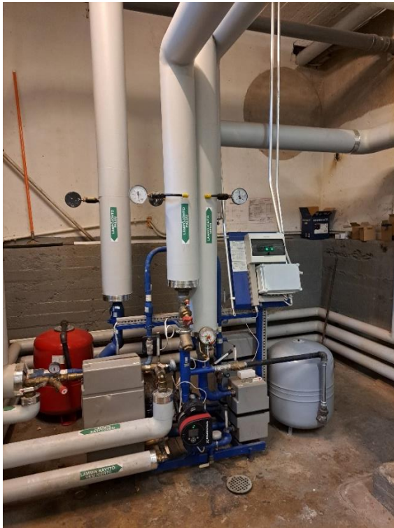
Kuva LVI 7: Kaukolämmön siirrinpaketti
