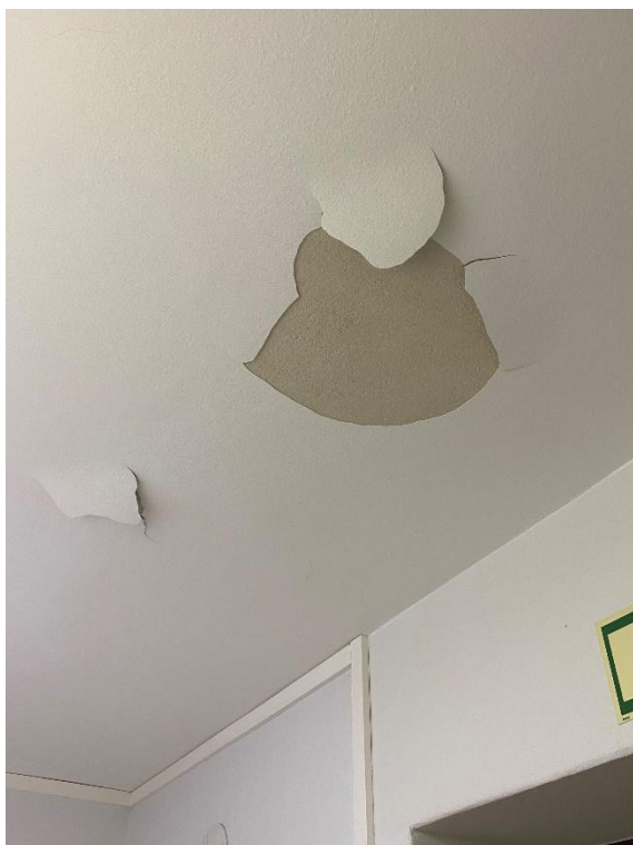
Kuva 19: Hallinto-osa; katon pinta irti
