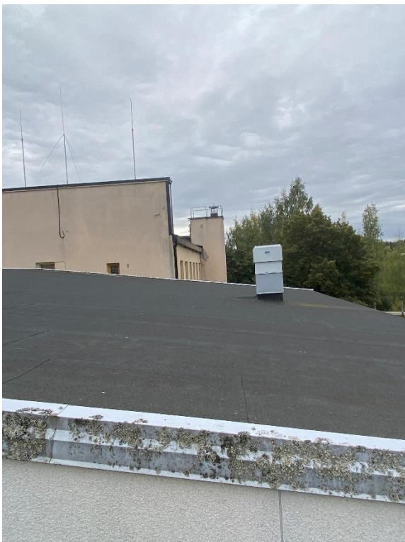
Kuva 17: Ylempi bitumikatto kunnossa.
