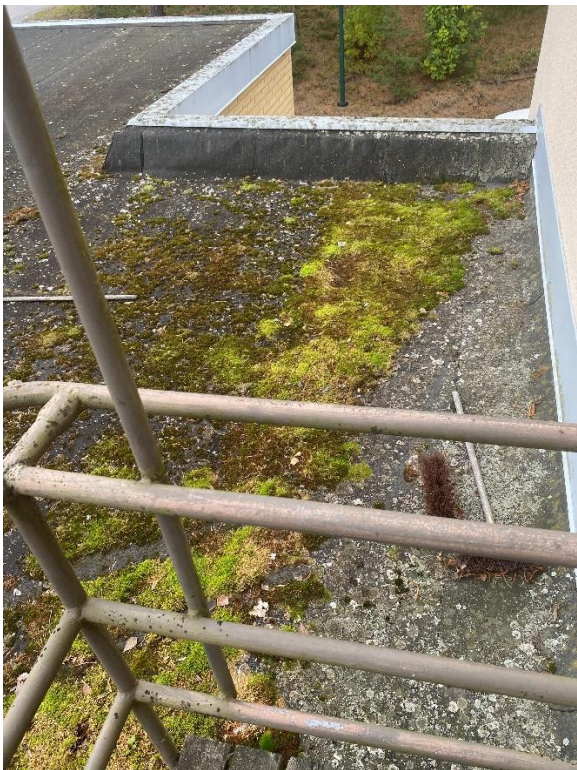
Kuvat 13 ja 14: Bitumikatoilla sammaleen poisto aiheellista.
