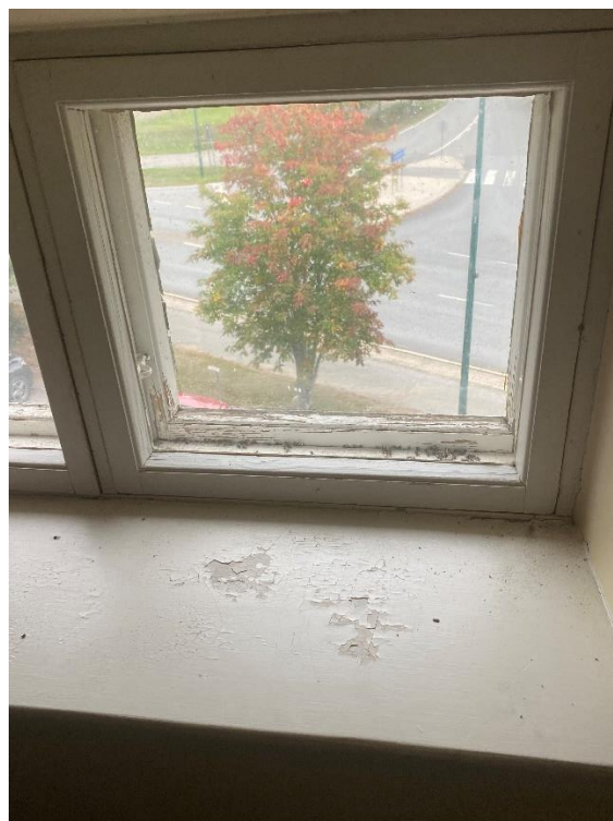
Kuva 20: Porrashuoneen ikkuna ja smyyki huonossa kunnossa
