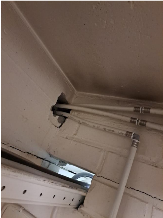
Kuva LVI 3: Vesijohtojen uusimisen jälkeen on seinäläpivientejä jäänyt paikkaamatta
