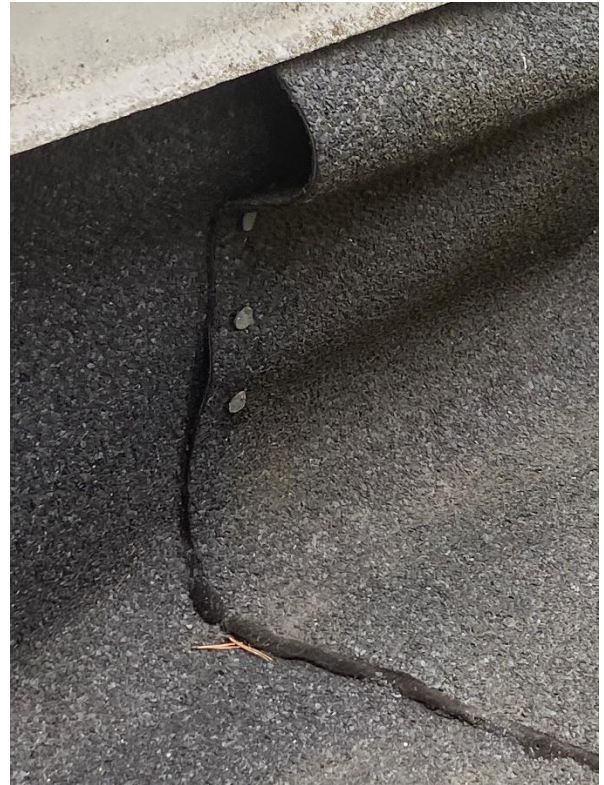
Kuvat 15 ja 16: Kattoikkunat kunnossa, mutta bitumikerman ylösnostot irti => vuotopaikka
