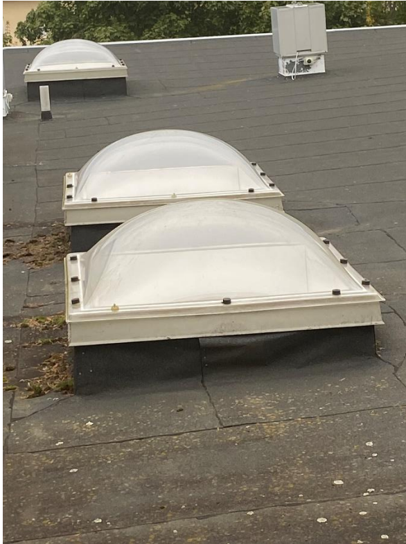
Kuvat 15 ja 16: Kattoikkunat kunnossa, mutta bitumikerman ylösnostot irti => vuotopaikka
