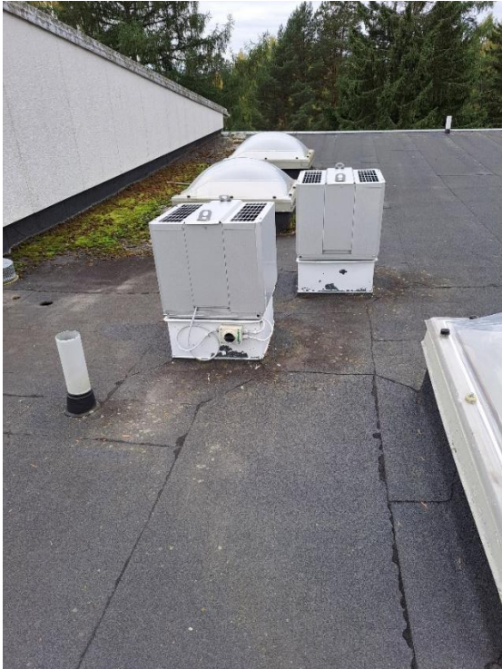
Kuva LVI 12: Huippuimureita, ikäarvio 5-10 vuotta
