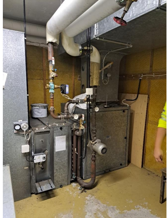
Kuva LVI 3: Vesijohtojen uusimisen jälkeen on seinäläpivientejä jäänyt paikkaamatta
