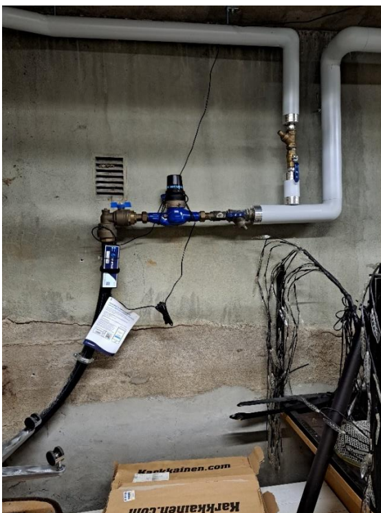
Kuva LVI 5: Etäluettava vesimittari
